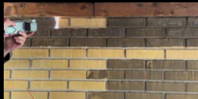
Afrensning af sod på murværk efter brandskabe
